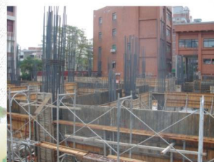
▲科學館目前施工狀況，工程進度非常順利。
