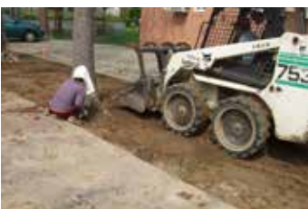
▲ 學務處前停車場整建工程
