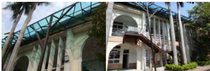
▲ 樓梯改善工程-雨遮
