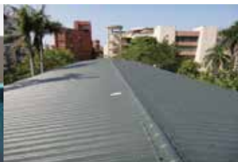
▲ 行政大樓屋頂防水隔熱工程
