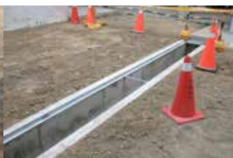
▲ 舊化工大樓後方水溝工程
