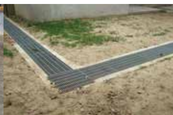
▲ 舊化工大樓後方水溝工程
