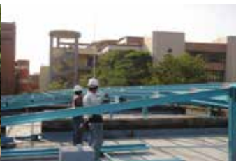
▲ 行政大樓屋頂防水隔熱工程
