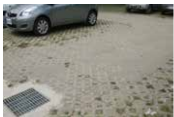
▲ 教務處後方停車場改善工程
