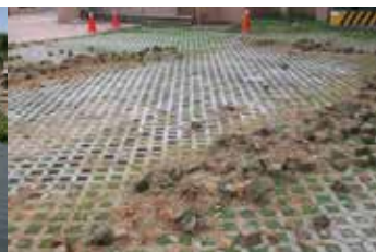
▲ 教務處後方停車場改善工程
